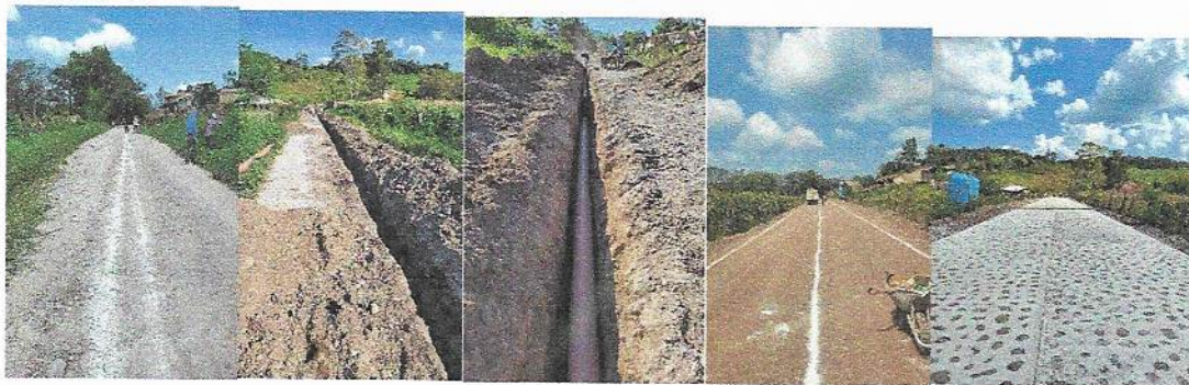
CONSTRUCCION DE LINEA DE DRENAJE EN CALLE PRIVADA MANUEL SANCHEZ DE LA LOCALIDAD DEL AGOSTADERO MONTO TOTAL= $45,500.00
