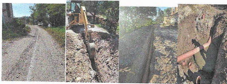
CONSTRUCCION DE LINEA DE DRENAJE Y EMPEDRADO AHOGADO EN CONCRETO EN LA CALLE ROMERO DE LA LOCALIDAD DE SAN PEDRO MUNICIPIO DE ATENGOMONTO TOTAL= $1,405,749.31.
