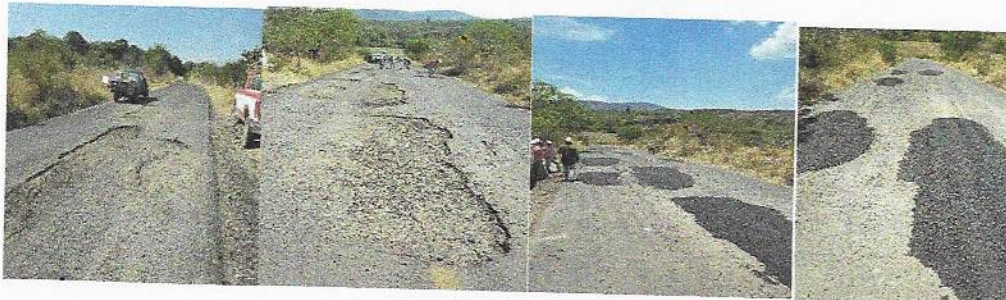
BACHEO DE TRAMO CARRETERO CRUCERO ATENGO – LA YERBABUENA DEL MUNICIPIO DE ATENGO MONTO TOTAL= $92,000.00
